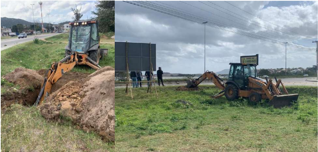
Figuras 23 e 24: Fotos da obra de extensão da rede de esgotamento sanitário do Bairro São João, em São Pedro da Aldeia. Fonte: Acervo Saneplac.
