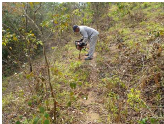
Figura 22 - Coveamento no setor M.2.1
