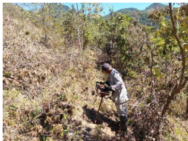
Figura 24 - Coveamento no setor M.2.1
