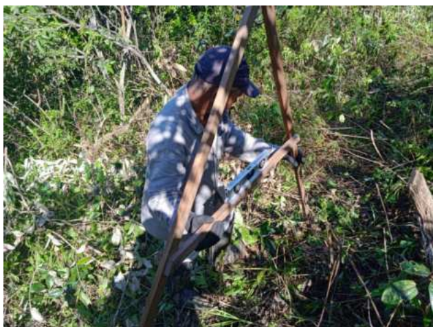
Figura 1 - Marcação e coroamento no setor M.2.3.
