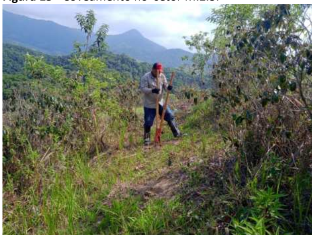
Figura 17 - Coveamento no setor M.2.3.
