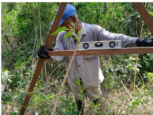
Figura 3 - Marcação e coroamento no setor M.2.2.
