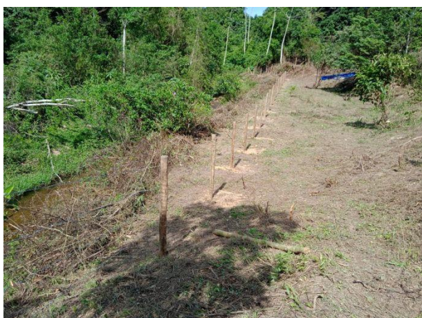
Figura 43 – Visão geral após colocação do arame guia.
