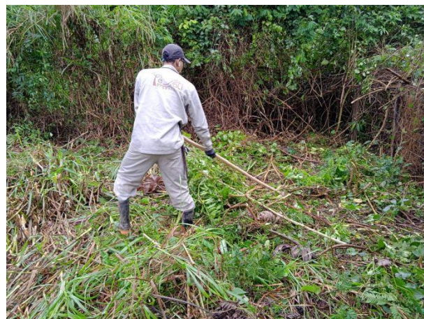
Figura 30 – Limpeza da área para cercamento setor M.1.
