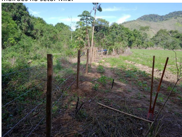
Figura 41 – Visão geral após colocação do arame.
