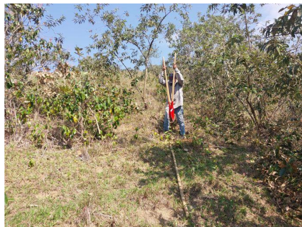
Figura 12 - Abertura das covas para colocação do moirões setor M.2.
