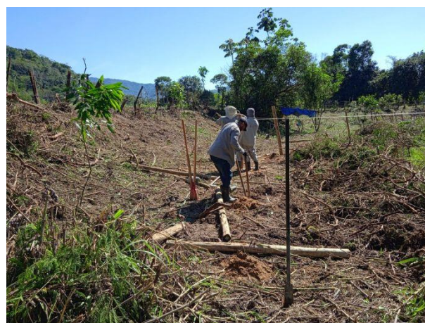
Figura 38 – Abertura das covas para colocação dos moirões no setor M.1.
