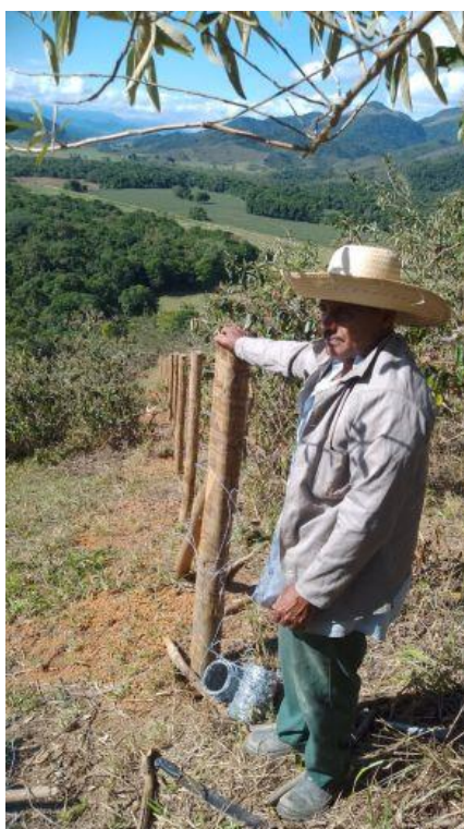
Figura 19 – Esticando o arame guia do cercamento.
