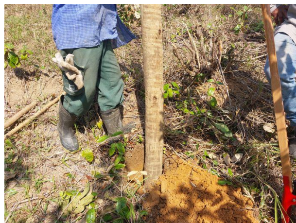
Figura 14 Colocação dos moirões da ponta do cercamento, setor M.2.
