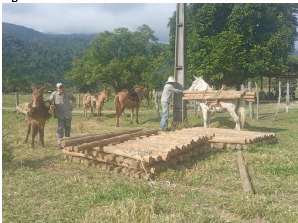
Figura 3 – Moirões de eucaliptos para execução da cerca.
