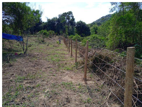
Figura 42 – Visão geral após colocação do arame.
