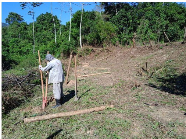
Figura 39 – Abertura das covas para colocação dos moirões no setor M.1.
