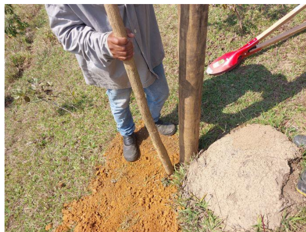
Figura 16 - Abertura das covas para colocação do moirões setor M.2.
