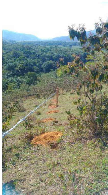
Figura 18 – Esticando o arame guia do cercamento.
