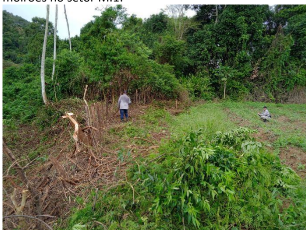
Figura 35 – Colocação do moirões setor M.1.
