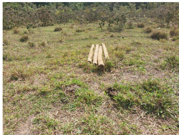
Figura 6 – Espalhamento dos moirões pela área setor M.2.
