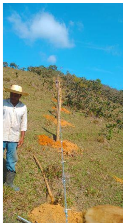
Figura 20 – Esticando o arame guia do cercamento.
