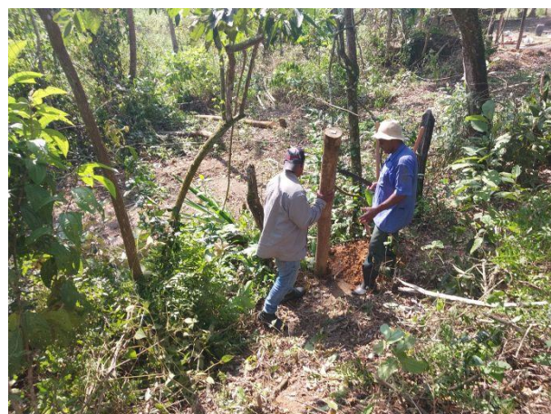
Figura 10 – Colocação dos moirões da ponta do cercamento, setor M.2.
