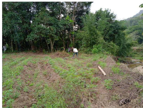
Figura 32 – Limpeza da área para cercamento setor M.1
