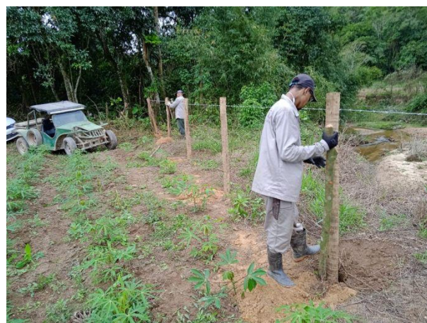
Figura 34 – Colocação do moirões setor M.1.
