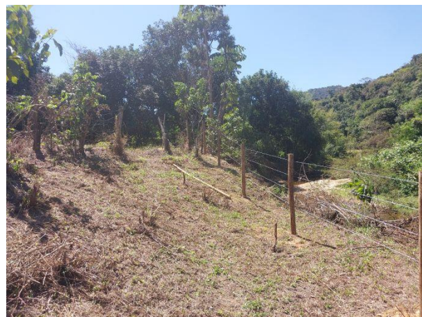
Figura 50 – Visão geral após colocação do arame.
