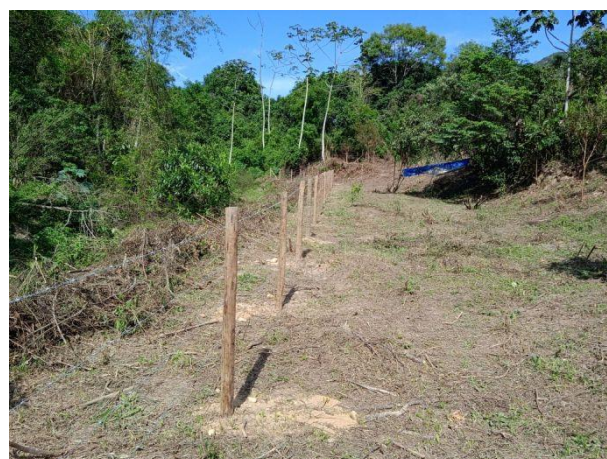
Figura 44 – Visão geral após colocação do arame guia.
