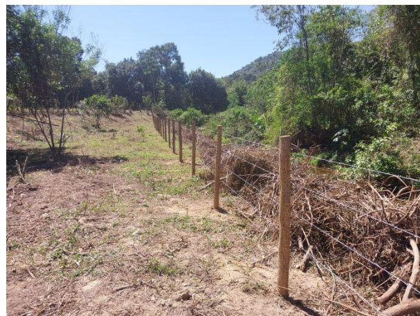
Figura 48 – Visão geral após colocação do arame.
