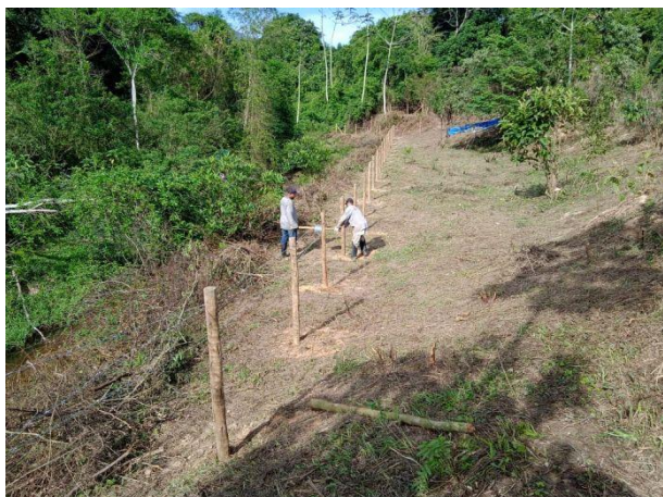
Figura 47 – Esticando o arame no setor M.1.
