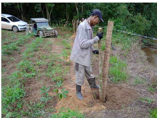
Figura 37 – Colocação do moirões setor M.1.
