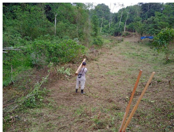
Figura 36 – Colocação do moirões setor M.1.
