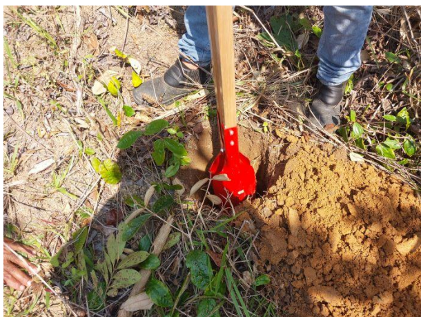
Figura 13 - Abertura das covas para colocação do moirões setor M.2.
