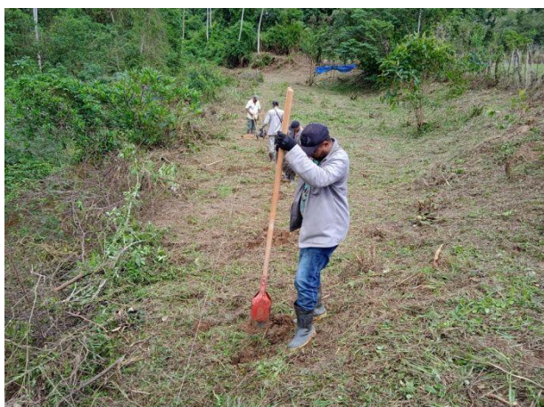
Figura 33 – Abertura das covas para colocação dos moirões no setor M.1.
