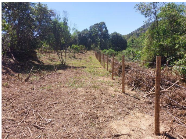
Figura 49 – Visão geral após colocação do arame.
