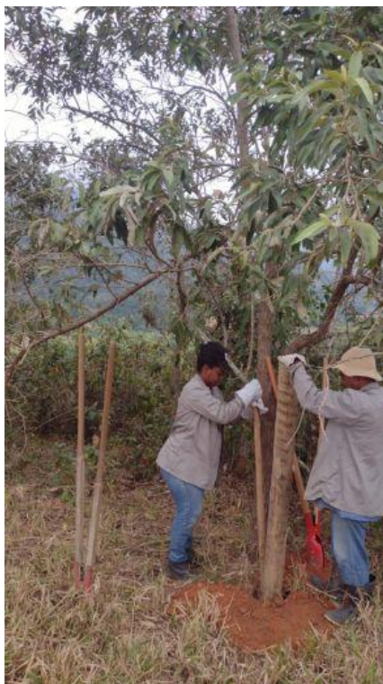
Figura 17 – Colocação dos moirões da ponta do cercamento, setor M.2.
