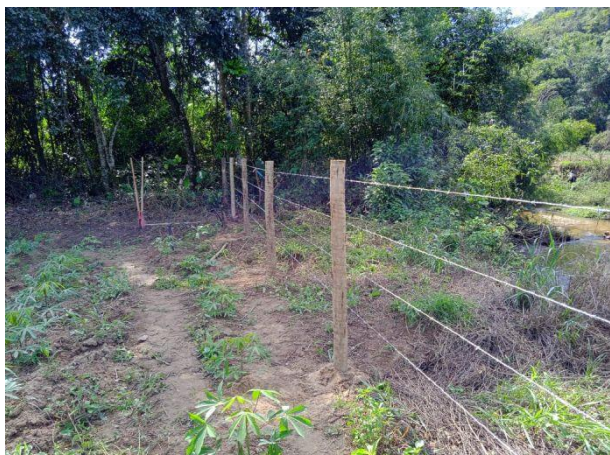
Figura 45 – Visão geral após colocação do arame.
