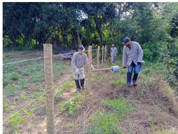
Figura 46 – Esticando o arame no setor M.1.
