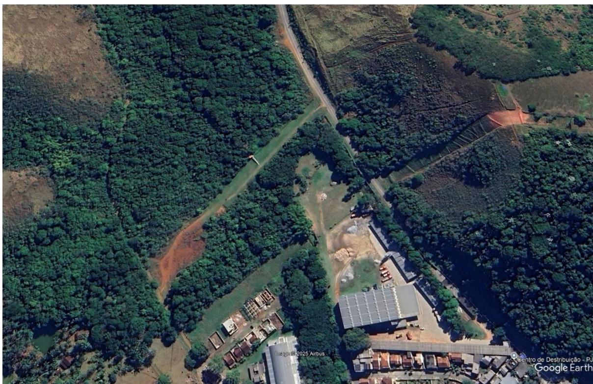
Figura 5.12 – Reservatório de retenção de Casimiro de Abreu. Fonte: GoogleMaps, 2025.
