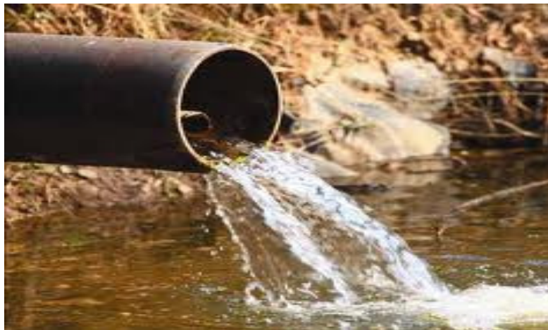
Figura 7- Lançamento de efluentes em corpos hídricos
