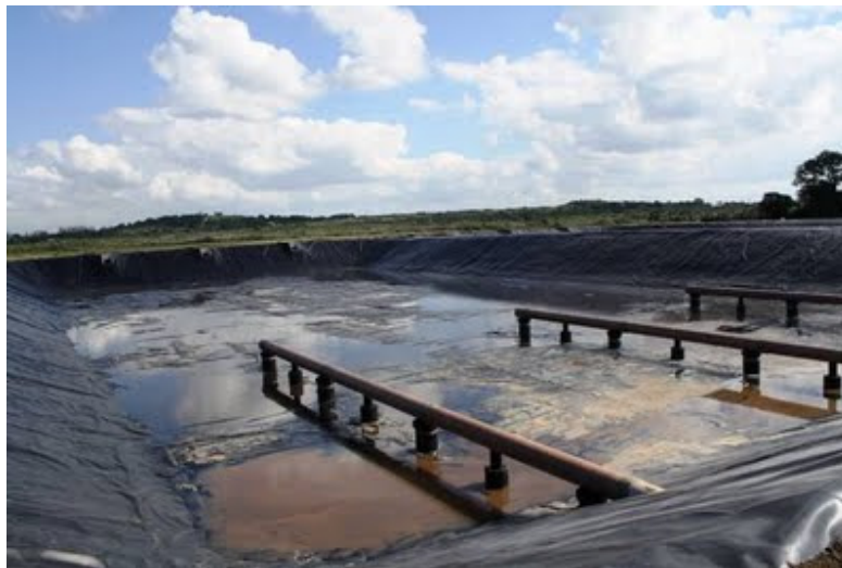
Figura 34- A Estação de Tratamento (ETE) do Jardim Esperança, construída pela Prolagos, em Cabo Frio (RJ)
