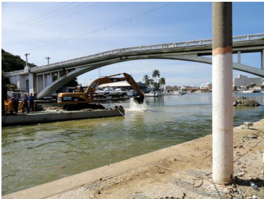
Figura 31- Máquina que trabalha no derrocamento entre a Ponte Feliciano Sodré e a Ponte Wilson Mendes, em Cabo Frio. Fonte: http://www.bigpop.com.br/site/index.php/meio-ambiente/recomeca-a-dragagem-na-lagoa-araruama/
