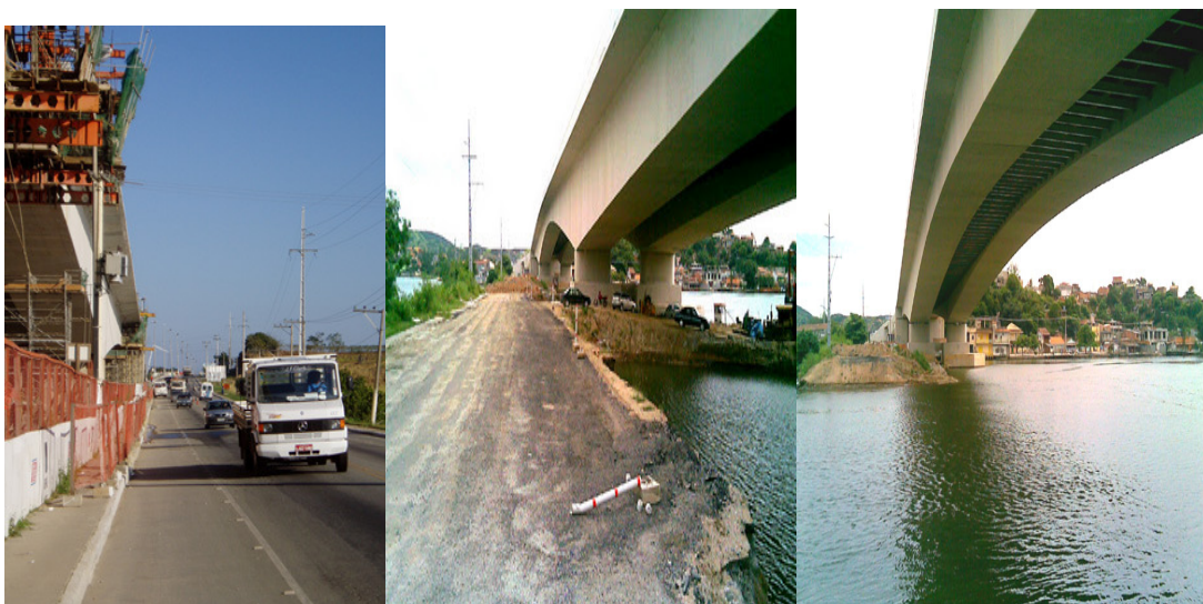
Figura 33- Construção da nova ponte sobre a Ponta do Ambrósio (Cabo Frio- São Pedro da Aldeia) Fonte: http://www.jornalprimeirahora.com.br/noticia/6019/Pontes-estao-sendo-feitas-com-mao-dupla-e-com-duas-pistas-de-rolamento
