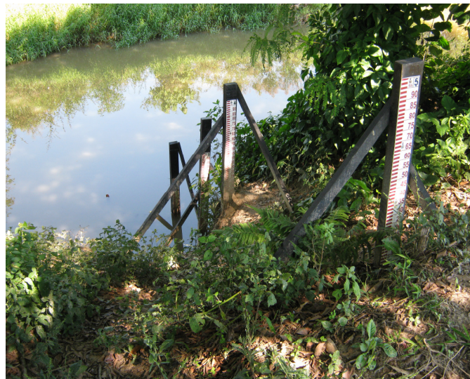
Figura 10: Régua fluviométrica instalada no Rio Capivarí. Estas réguas já estavam instaladas quando iniciamos o estudo, mas não conseguimos obter nenhuma equação para elas.
