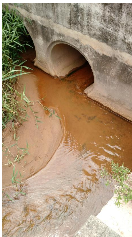
Figura 06: Visão do ponto 12 (Condomínio Industrial - C. Abreu) com o rio canalizado sob a linha férrea.
