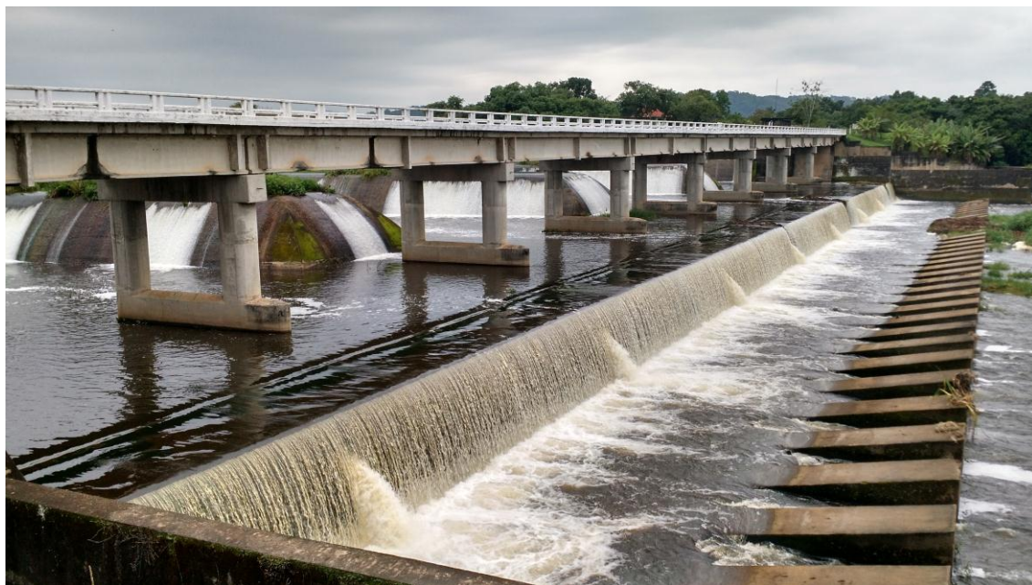
Figura 09: Imagem da barragem do reservatório no ponto 15 (Juturnaíba - barragem).
