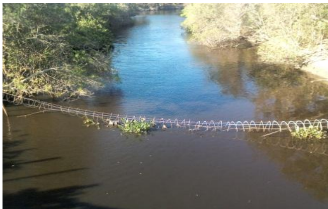
Figura 3 – Ponte da Malhada (a montante)
