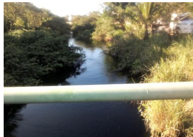
Figura 8 – Ponte Rodovia Amaral Peixoto (a jusante)
