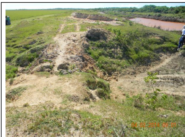
Foto 01- Detalhe de movimentação de terra próximo ao Rio Una.
