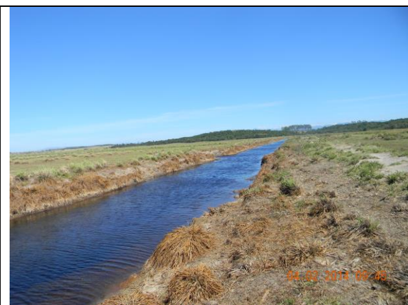
Foto 01- vista da vala de drenagem
