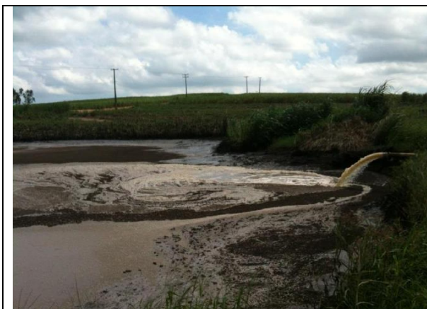
Foto 01- Vista do tanque de armazenamento de Vinhoto.
