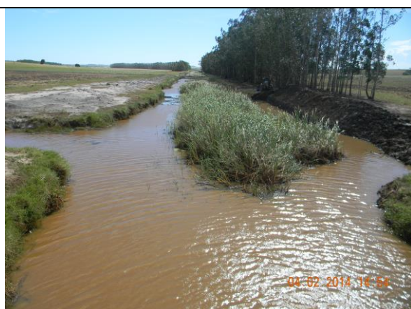
Foto 02- Vista do canal de drenagem à montante.
