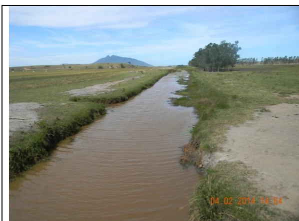
Foto 01- Vista do canal de drenagem à jusante.
